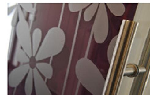
Drsno krilo: stekleno, steklo prozorno z vzorcem potiskane folije.
