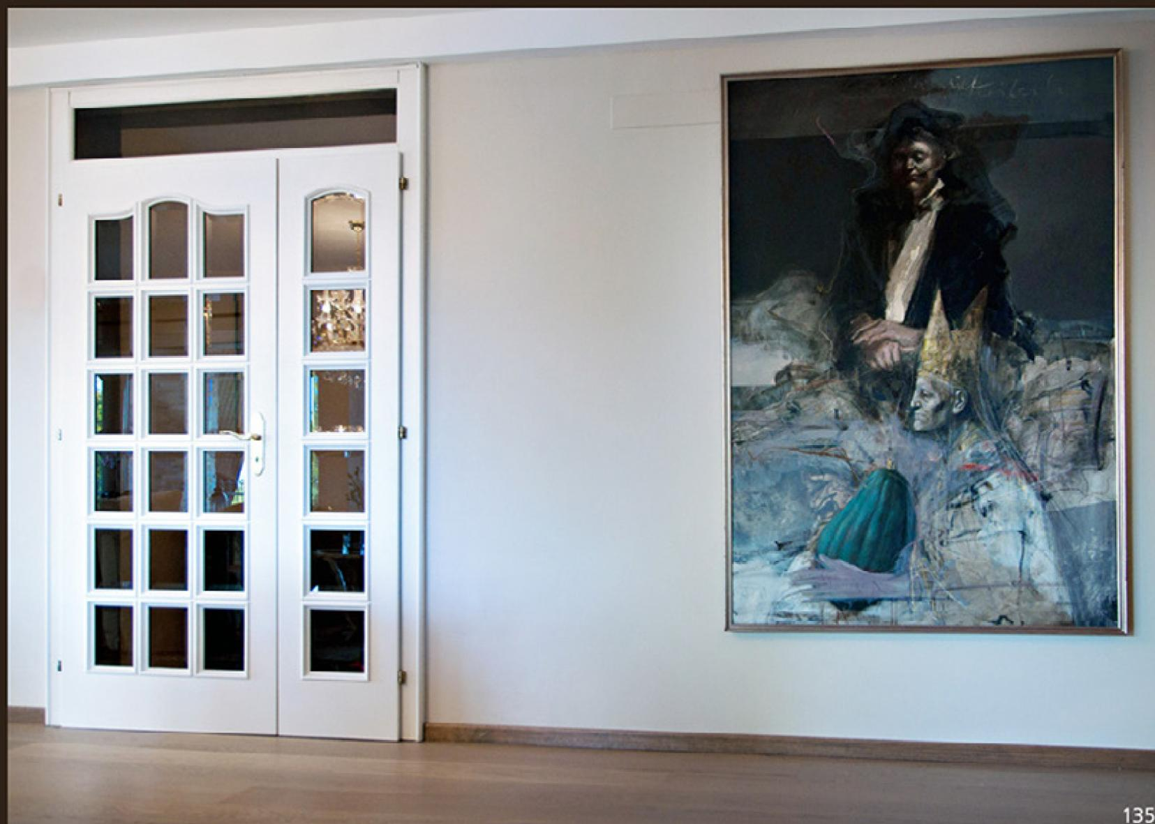
Krilo: stekleno z izrezi za steklo s profiliranimi letvicami, stransko svetlobo, površina pleskana po Ral lestvici.
